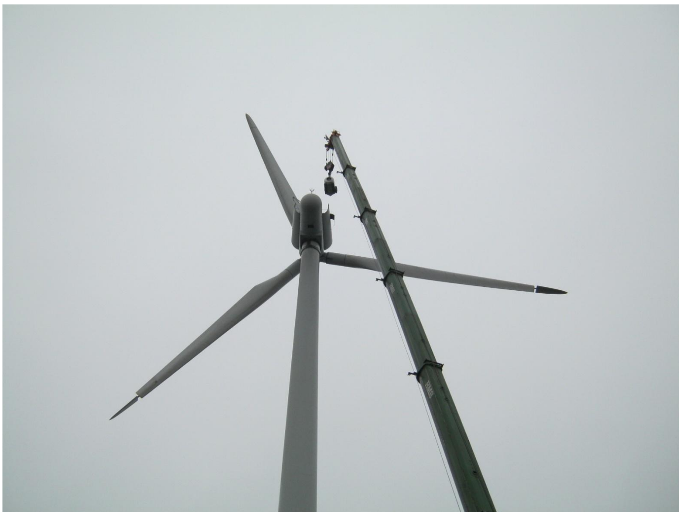
Figur 1: Udskiftning af generator mølle 6.
